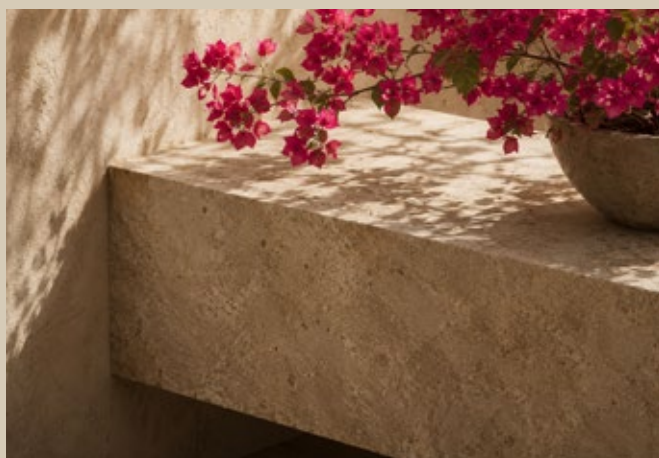
3. Continuidad material: estuco de cal, madera de roble y piedra local trabajada in situ.
